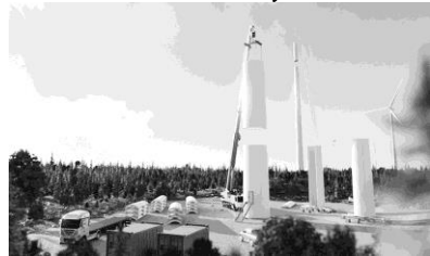
Mô phỏng quá trình lắp đặt turbine gỗ dạng module tại Thụy Điển.
